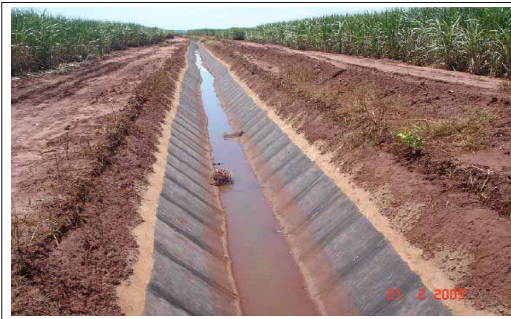
Fig 09 – Canal para transporte de vinaza revestido por asfalto.
