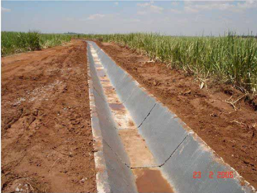
Fig 10 – Canal para transporte de vinaza revestido por concreto
